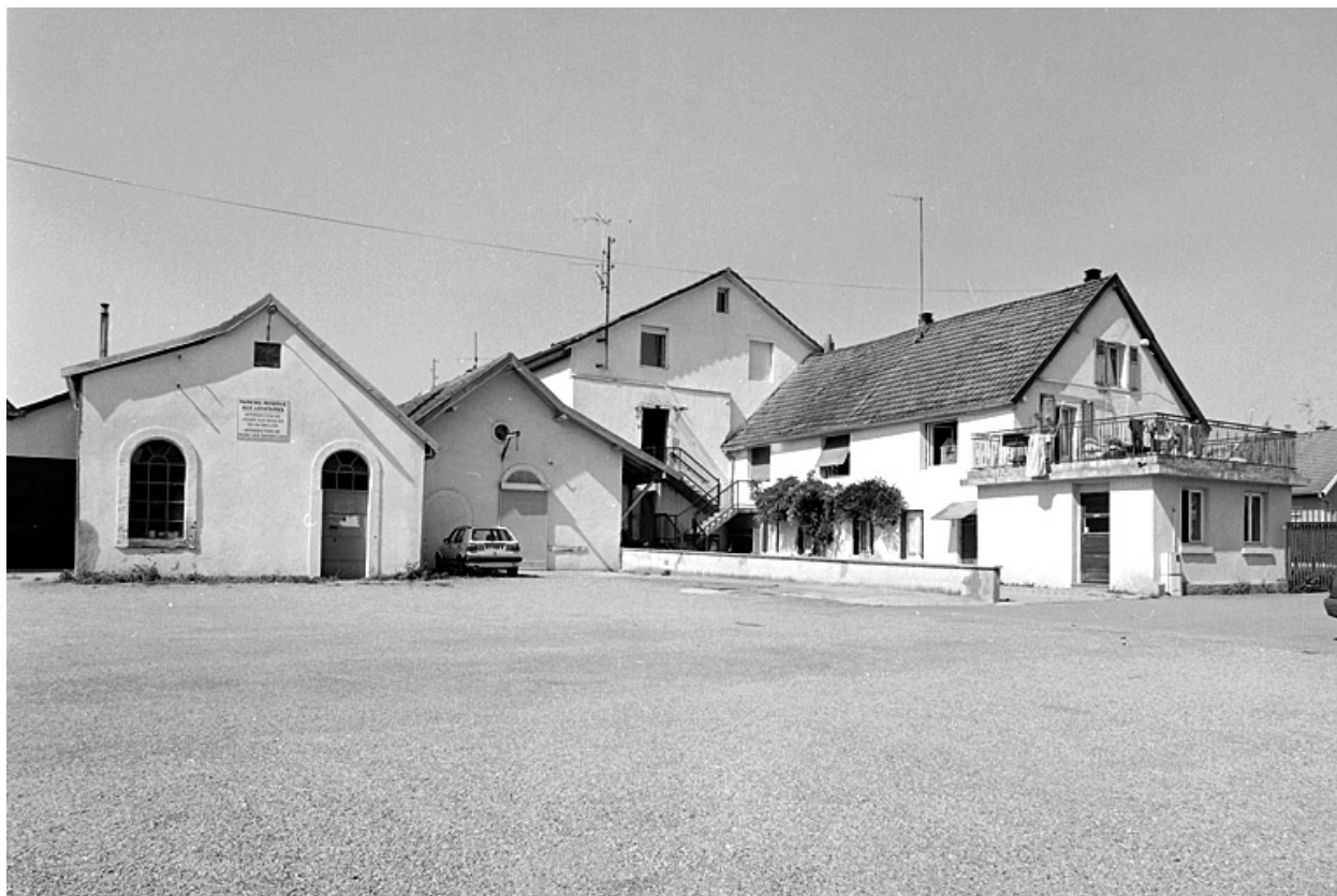
Pignons des ateliers depuis la cour.
