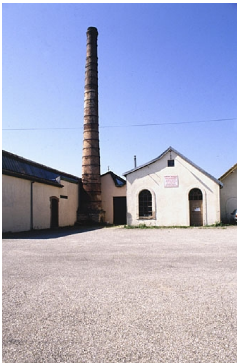
Cheminée et salle des machines.
