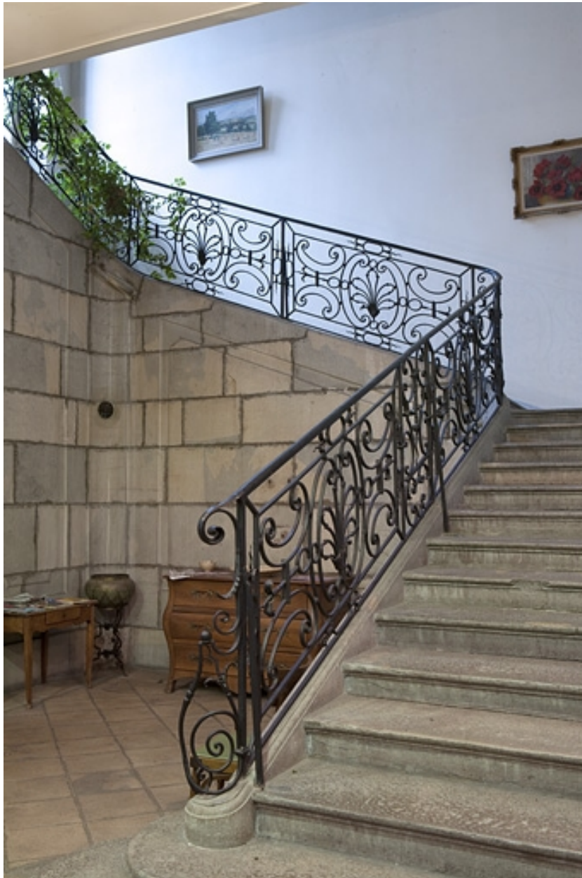
Intérieur, escalier : détail de la rampe en fer forgé.
