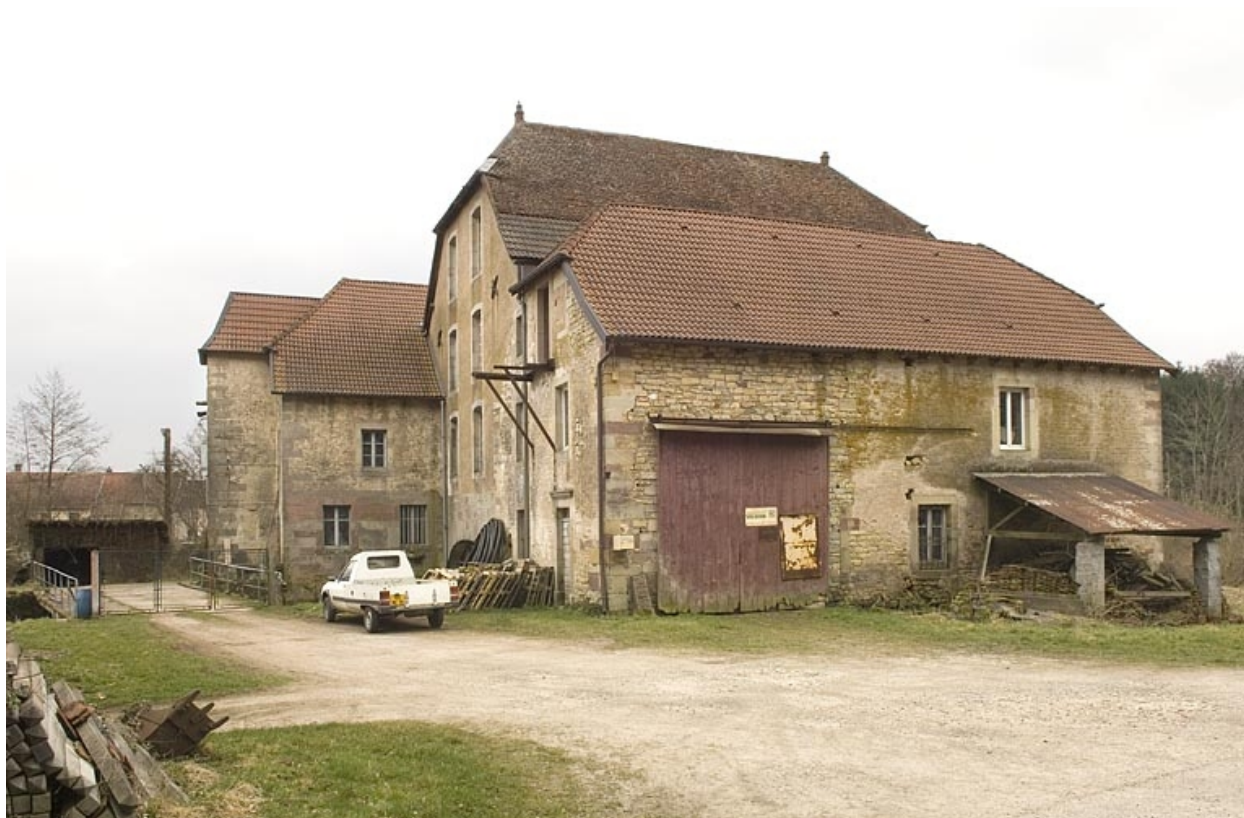
Vue depuis l'ouest.
