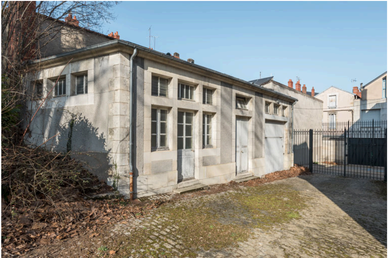
Façade sur la cour.
