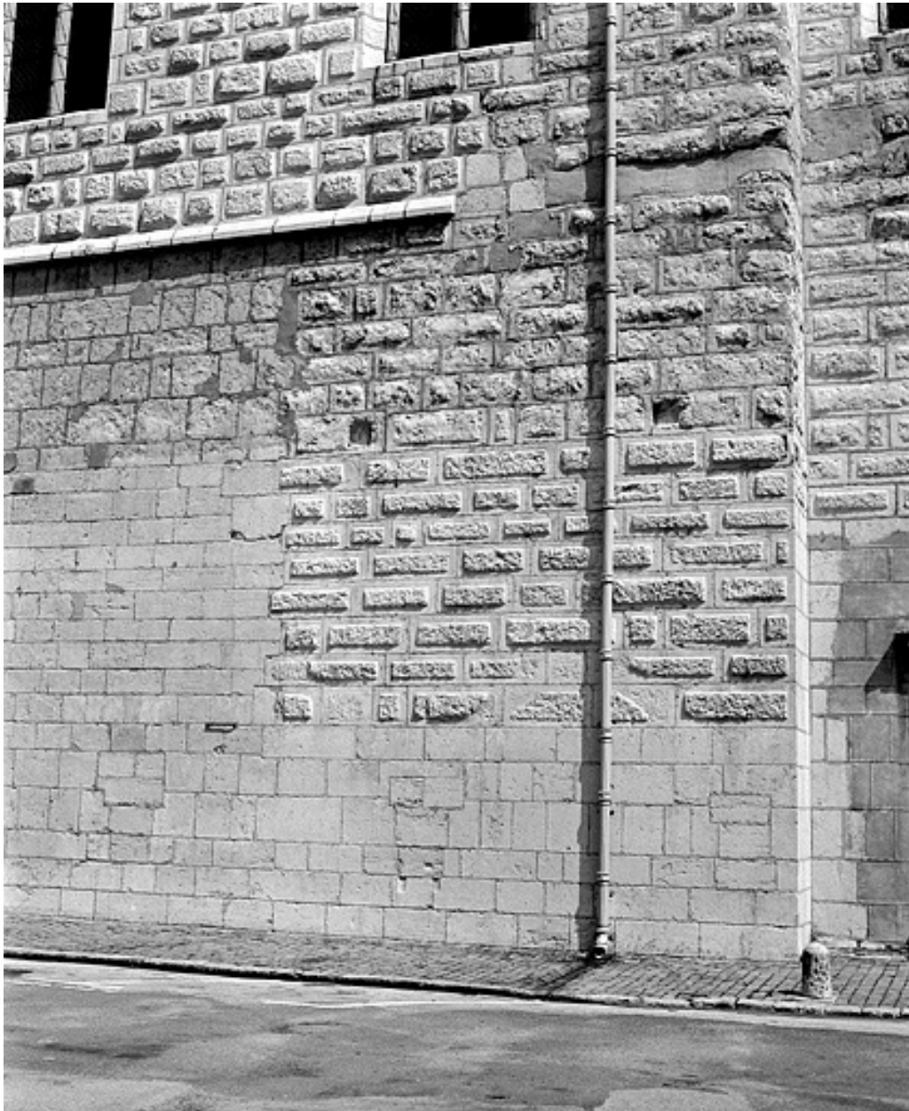
Détail du flanc sud : couture à hauteur de la troisième travée.
