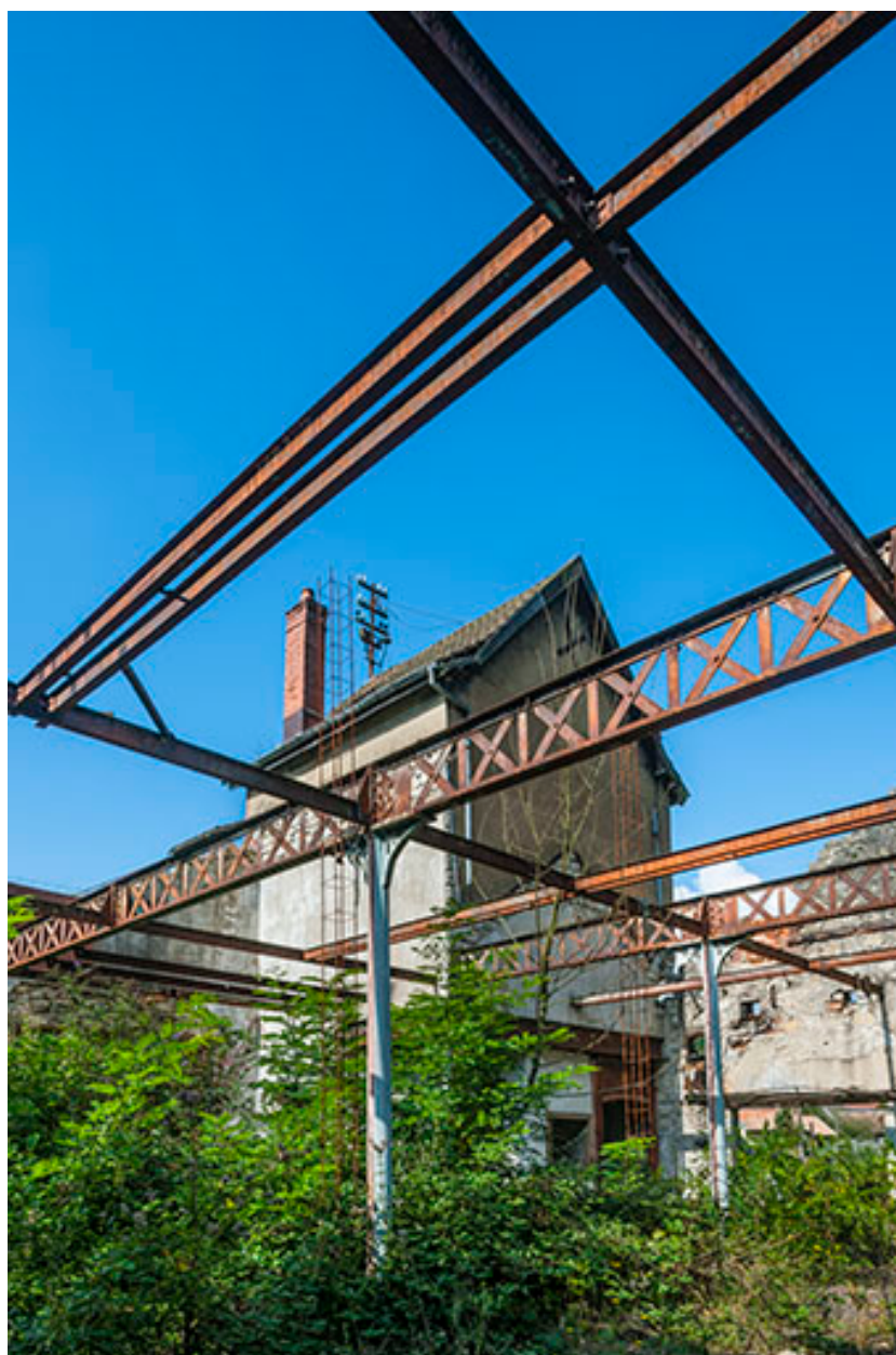
Charpente métallique de l'atelier de fabrication.
