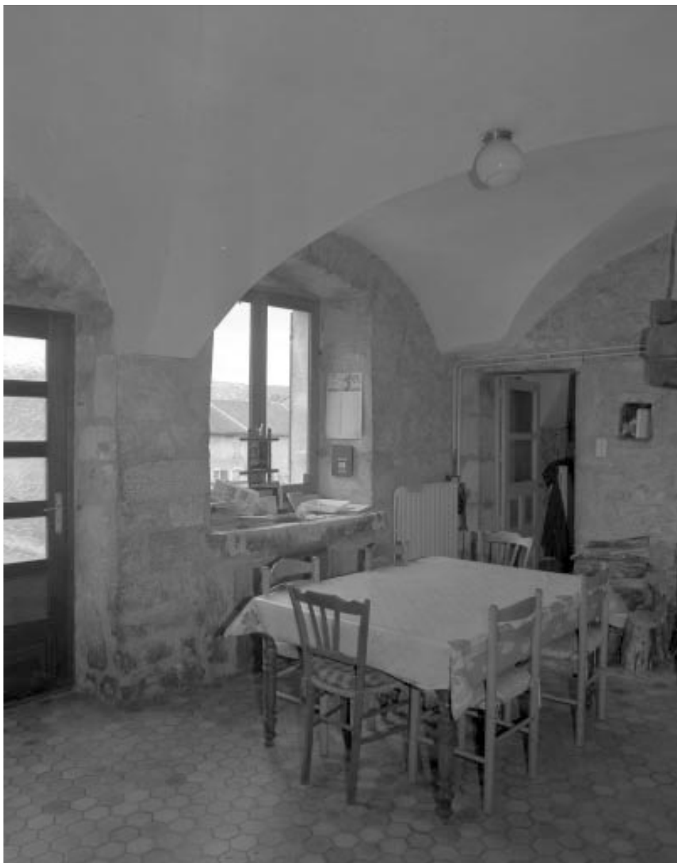
Intérieur du rez-de-chaussée : voûte d'arêtes.
