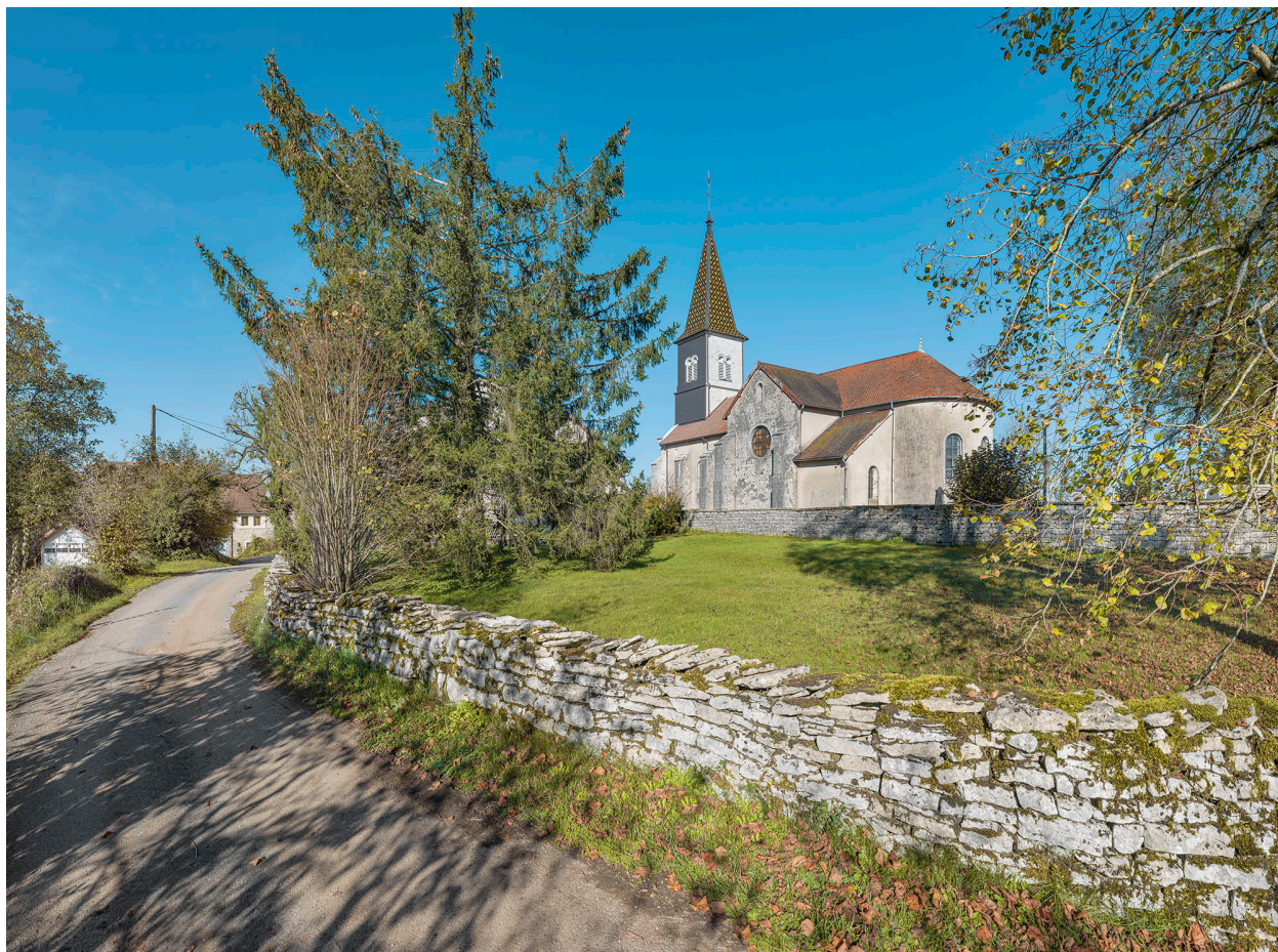
Vue d'ensemble : élévation sud et chevet.
