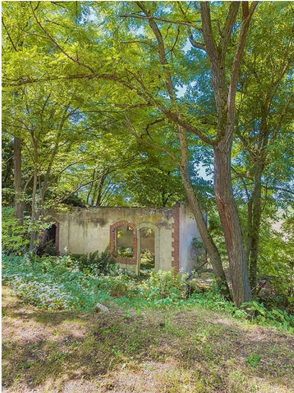
Vestiges d'un bâtiment (magasin ?), rive gauche.
