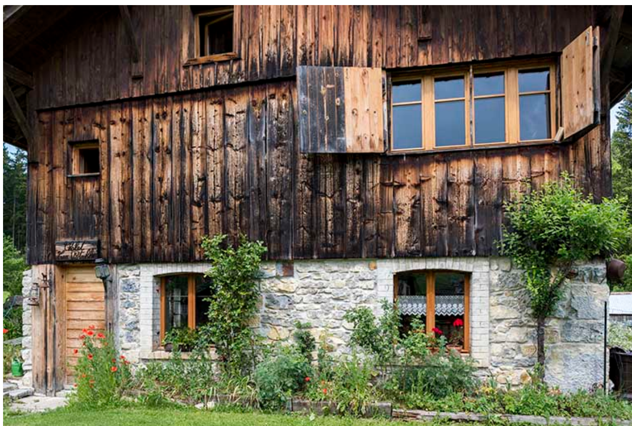
Façade antérieure : baies.
