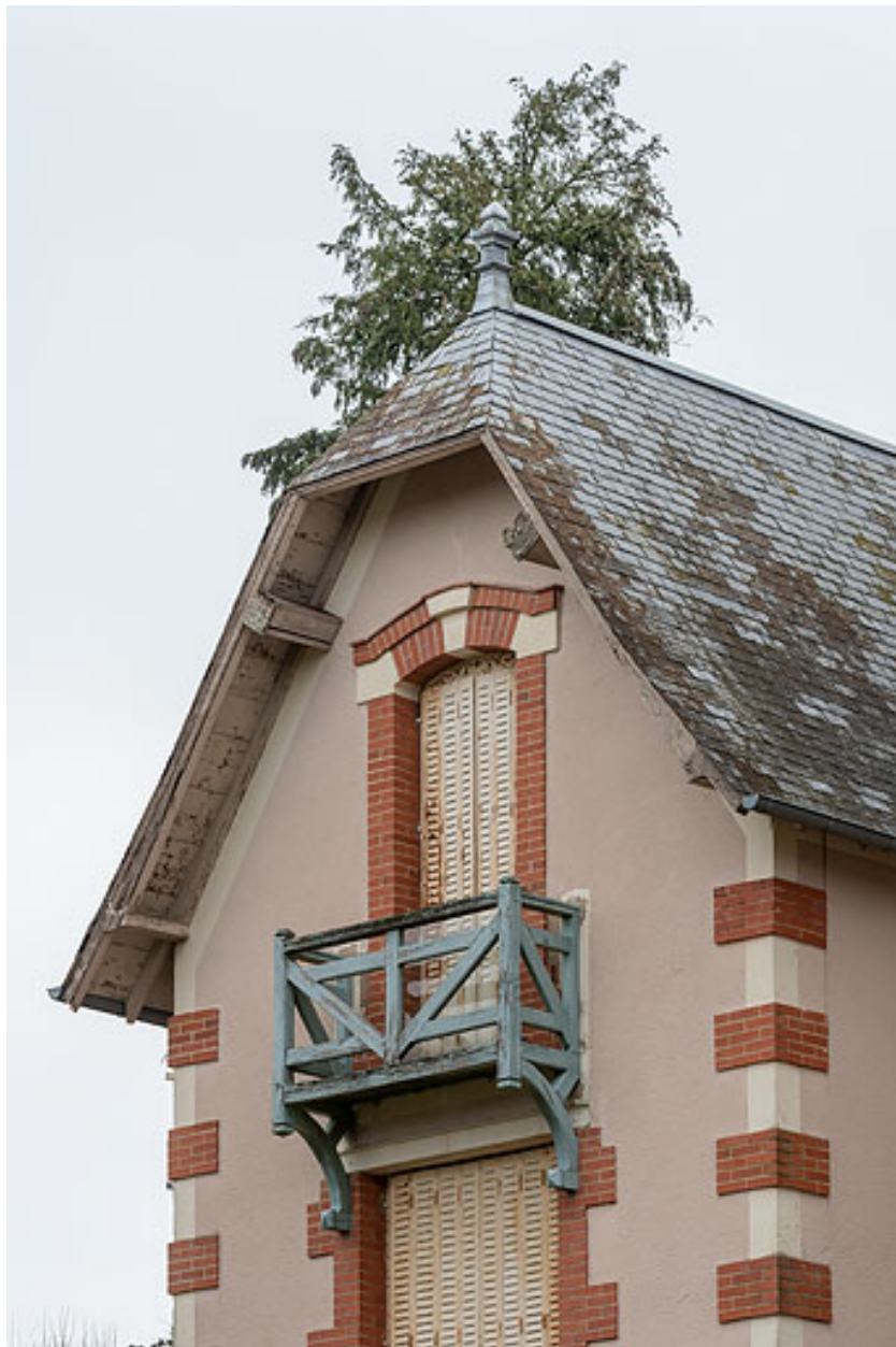
Mur-pignon en façade, demi-croupe en ardoise.
