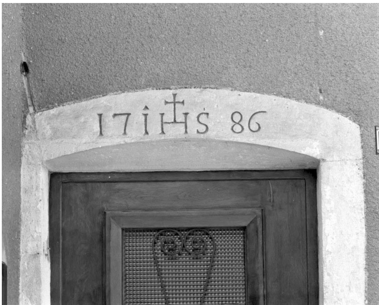
Linteau de la porte du rez-de-chaussée.
