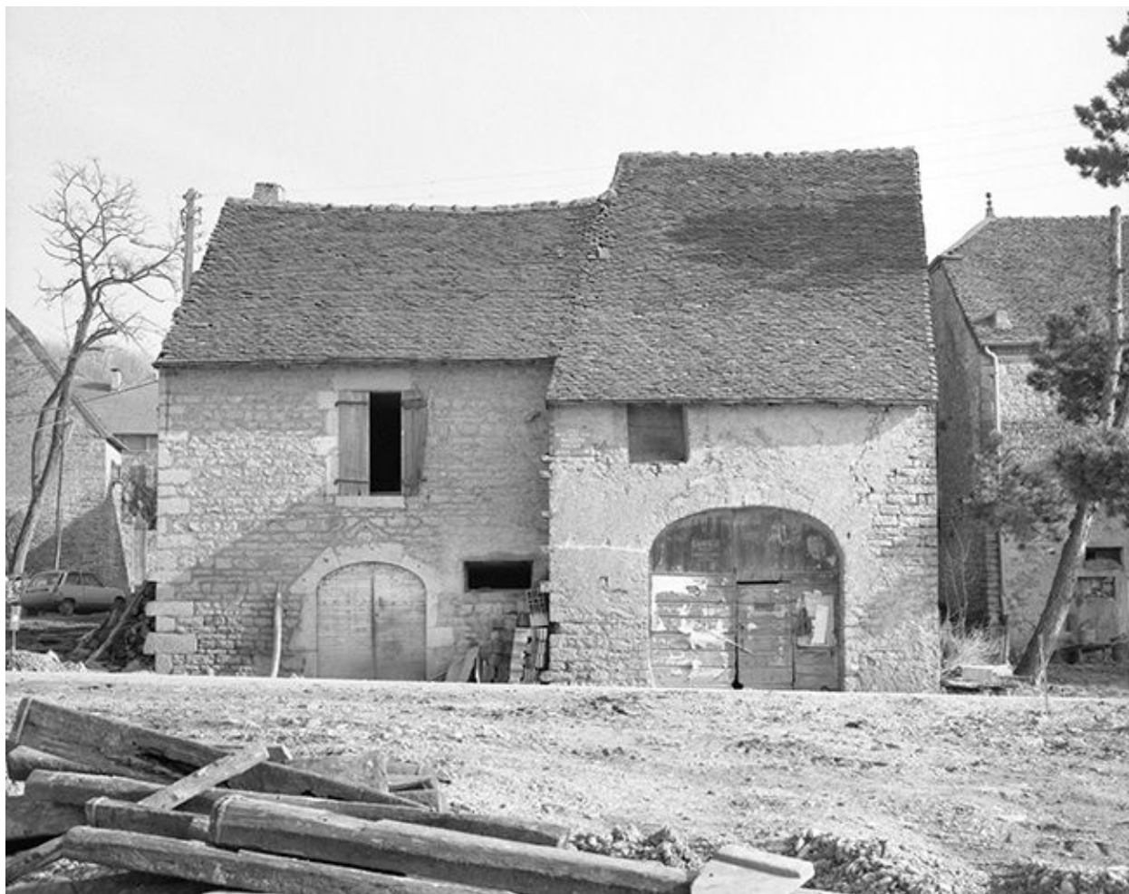
Ferme cadastrée 1959 AI 92 : façade antérieure.
