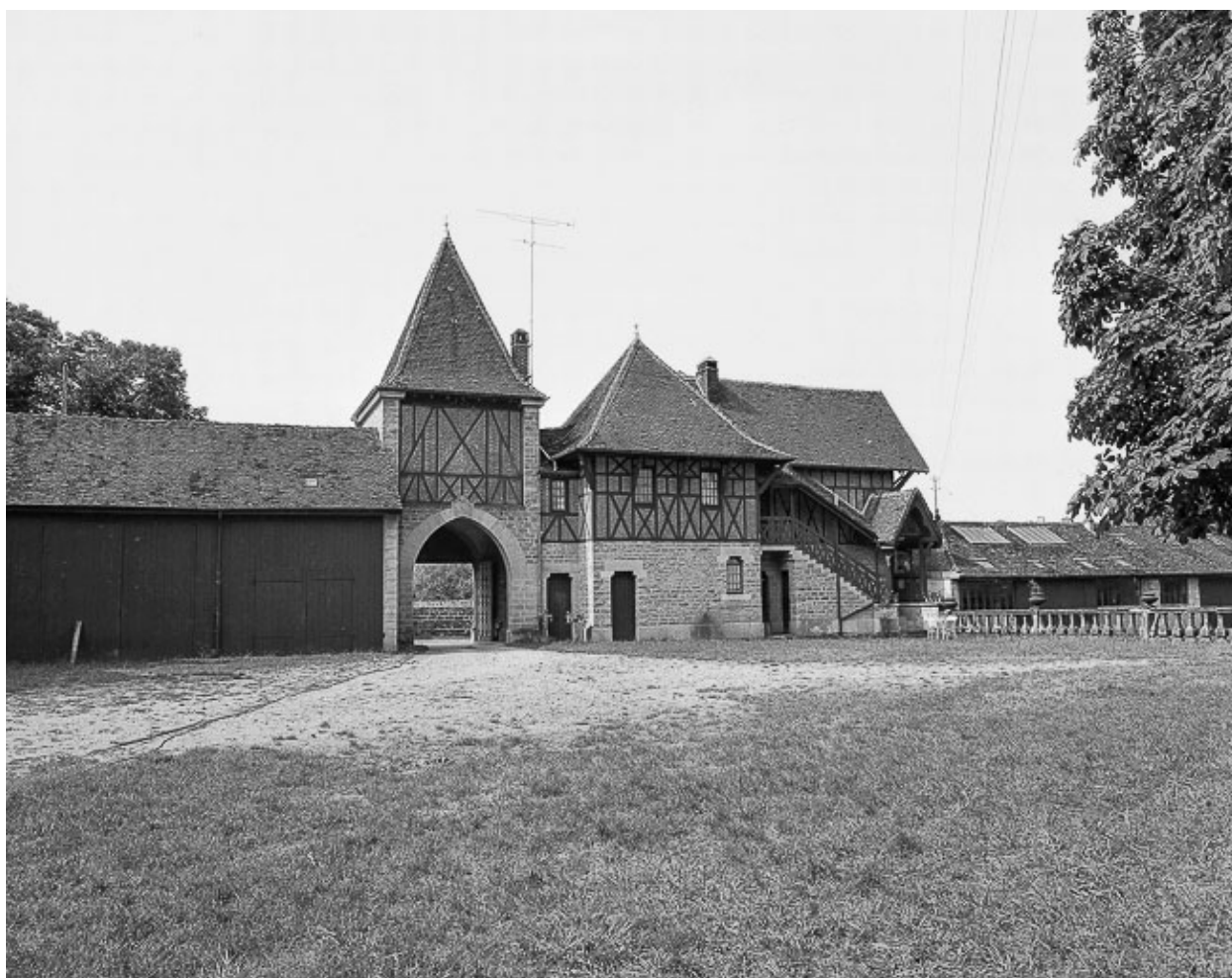
Bâtiment d'entrée : façade nord.
