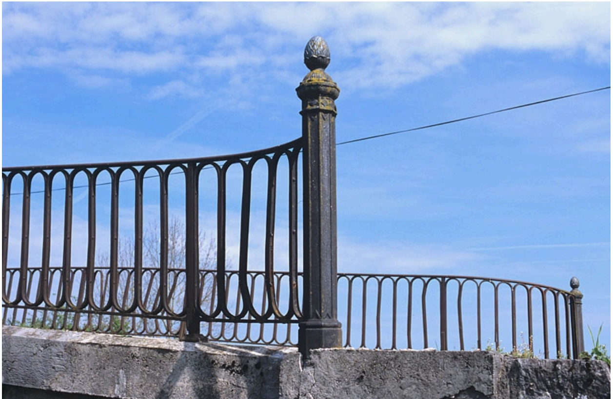
Potelet ouest du garde-corps nord.
