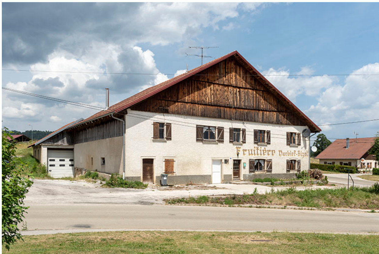
Façades antérieure et latérale gauche.
