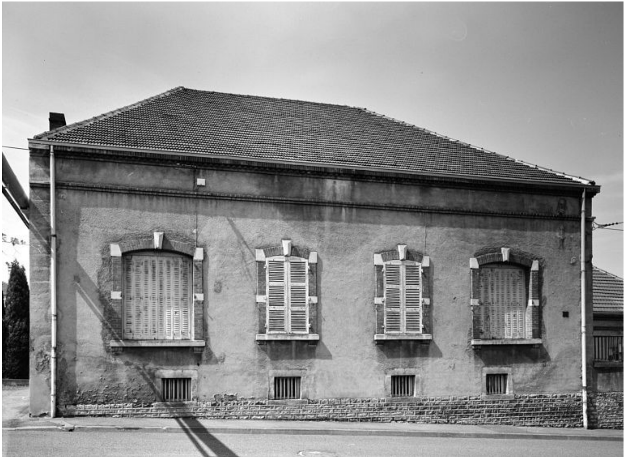
Façade postérieure de l'ancien logement du directeur, transformé en bureau après 1945.
