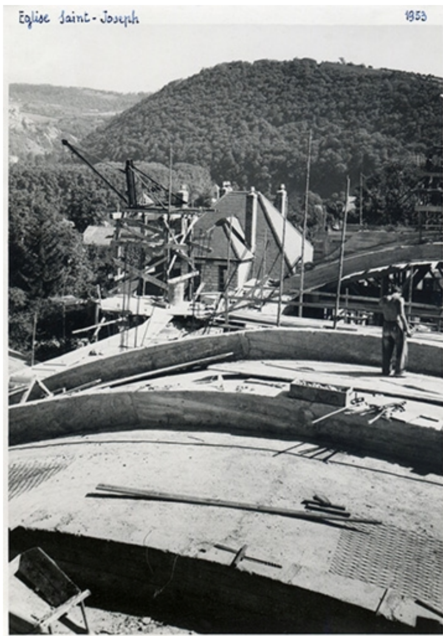
Chantier de l'église Saint-Joseph de Besançon : vue de la voûte en construction. 1953.
