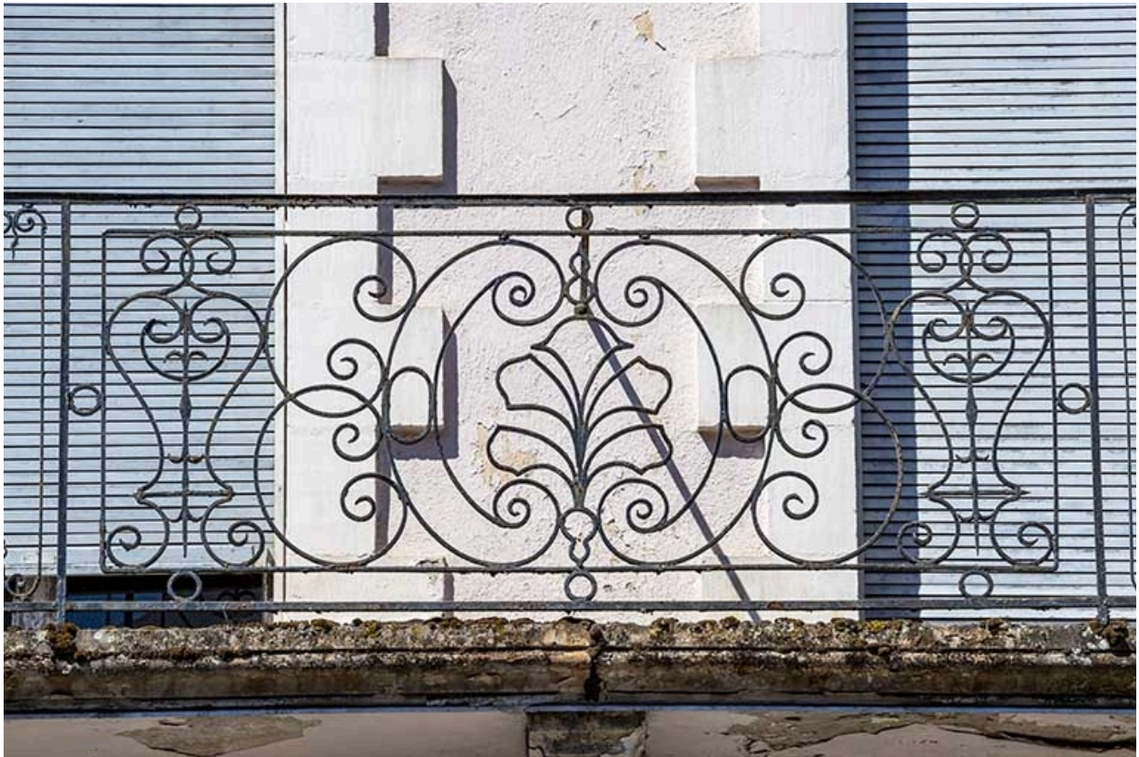
Façade est, garde-corps de balcon en fer forgé.
