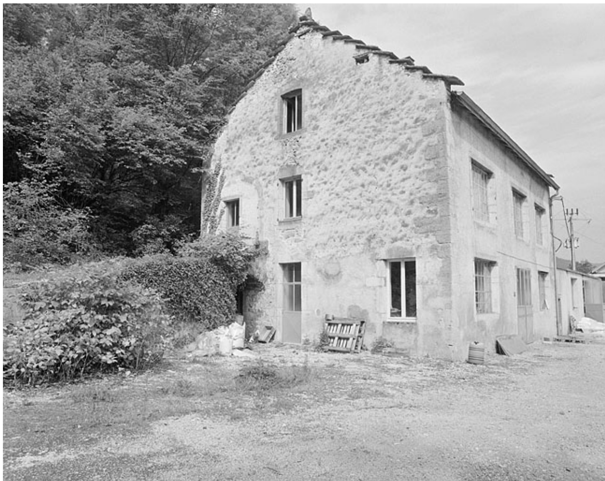
Façade antérieure et face gauche du moulin.
