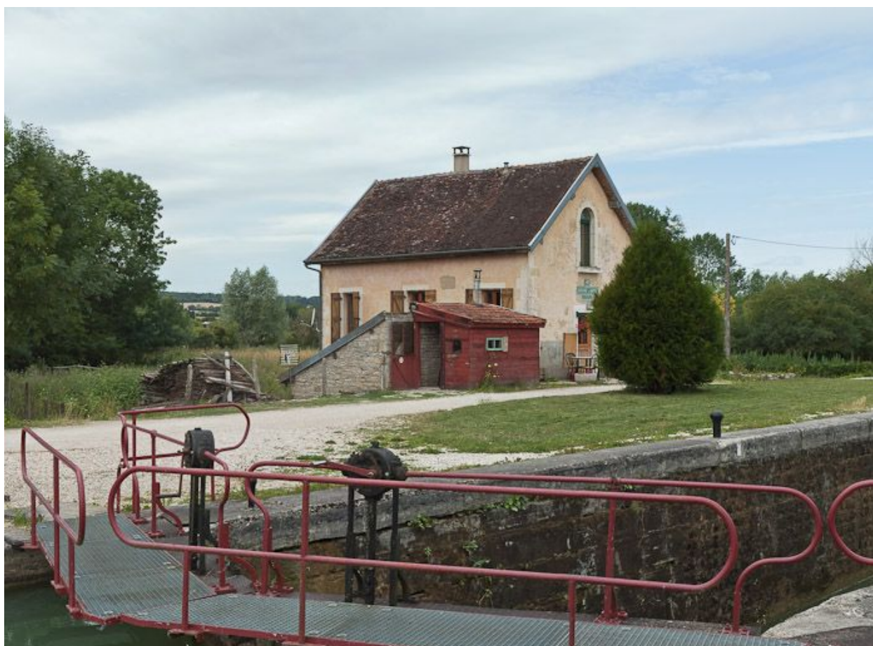
Vue d'ensemble du site d'écluse.
