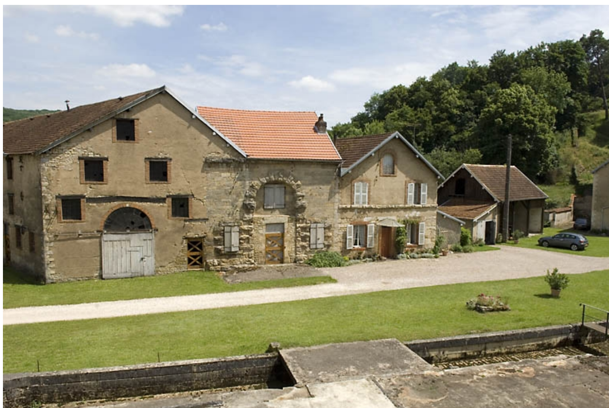
Façade sud du magasin industriel, de l'écurie et d'un logement.
