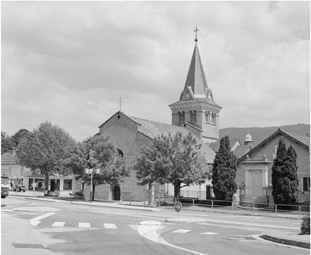
Vue de l'église depuis le sud-ouest.
