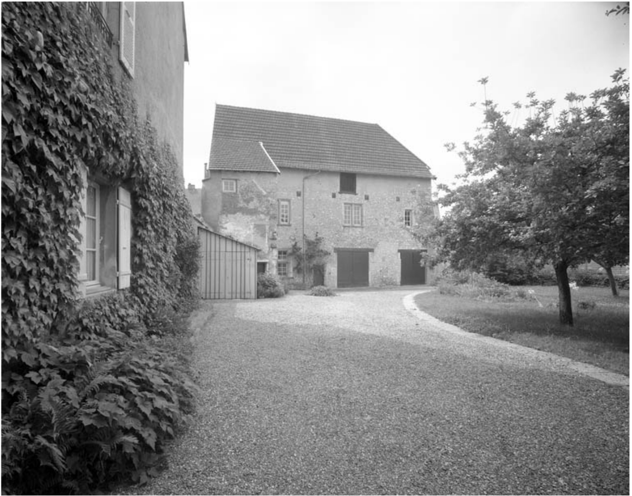
Partie gauche du couvent : bâtiment en fond de cour, de face.
