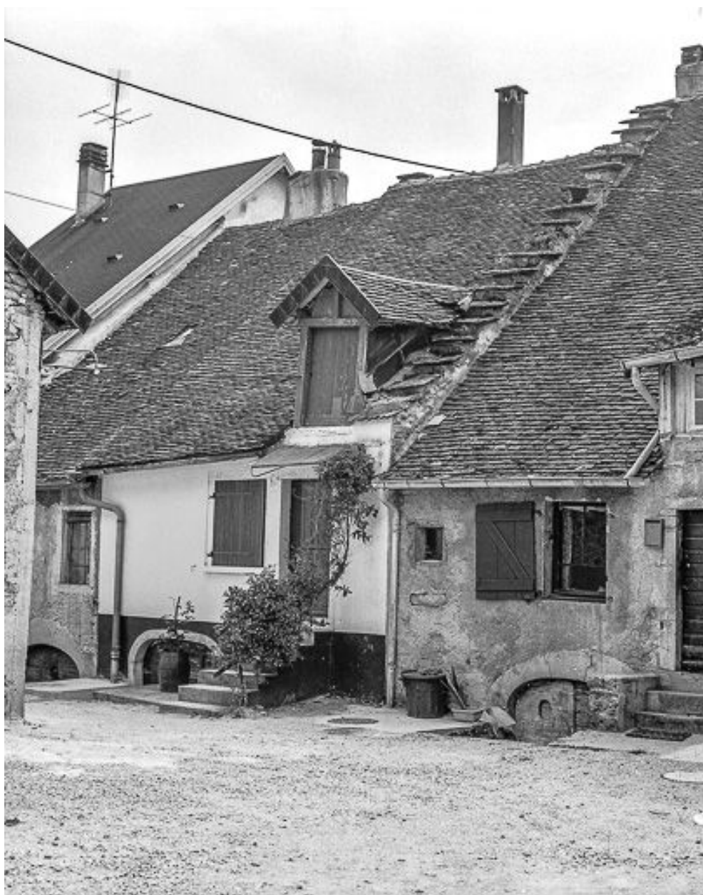
Maison : façade antérieure.
