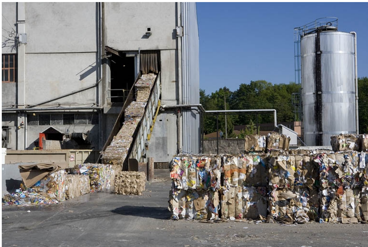
Atelier de trituration, tapis roulant, balles de matières premières et lessiveur.
