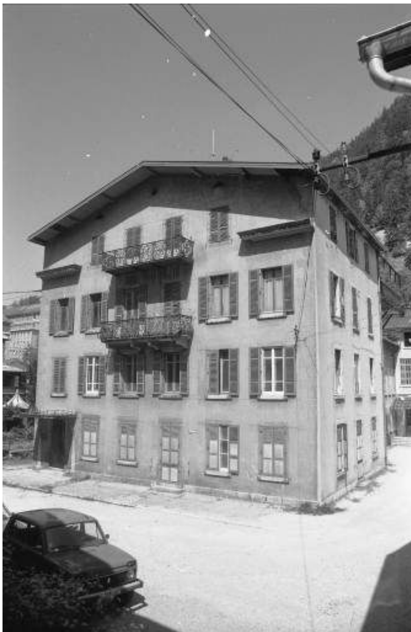
Logement patronal et anciens bureaux (1892) : façade antérieure.
