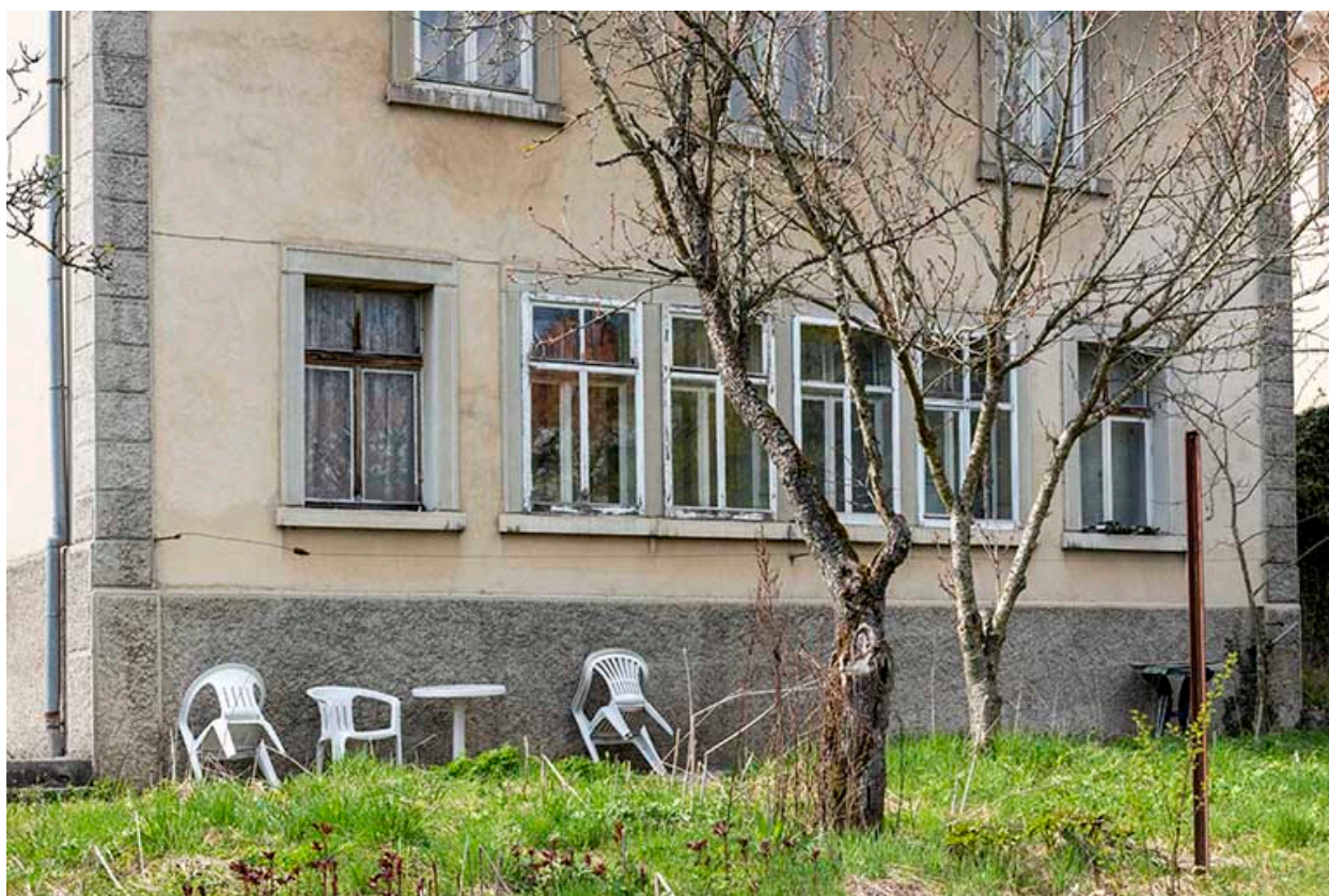
Façade postérieure : fenêtres multiples de l'atelier.
