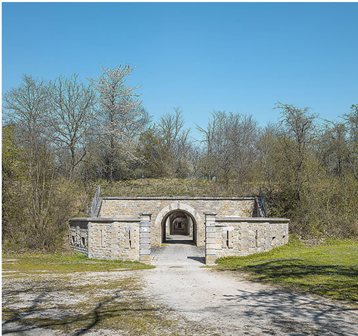
La redoute de Saint-Apollinaire : entrée de l'édifice (front de gorge).
