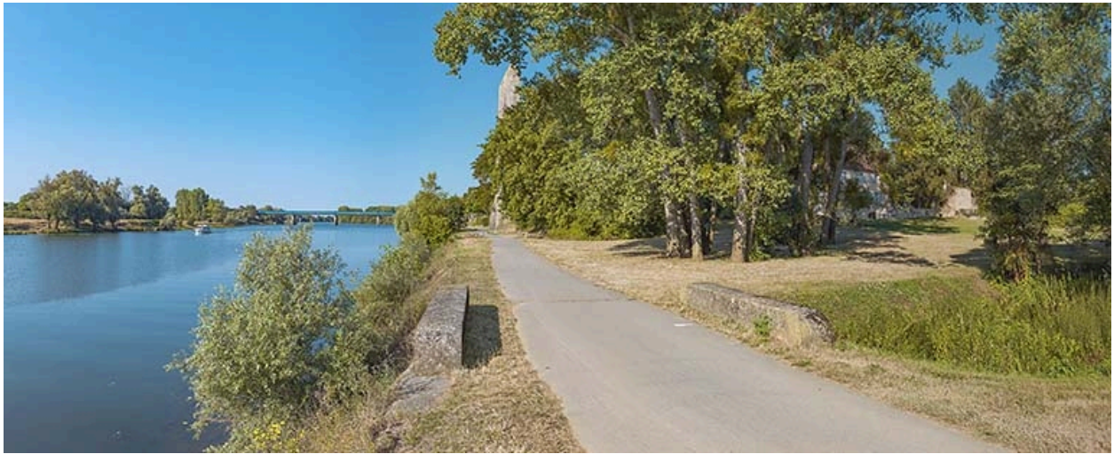
La digue de Chauvort, vue d'amont.
