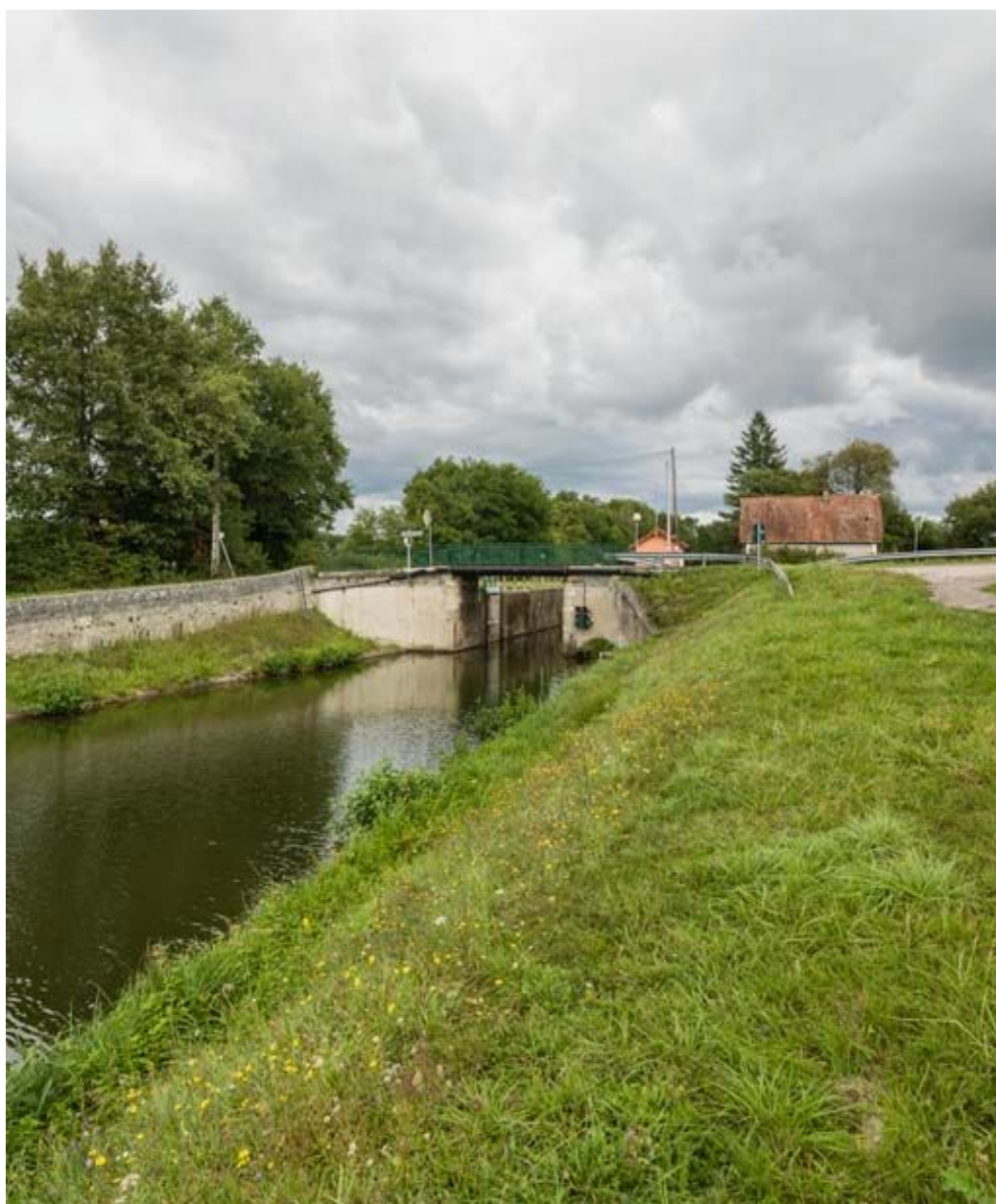
Vue d'ensemble du pont.
