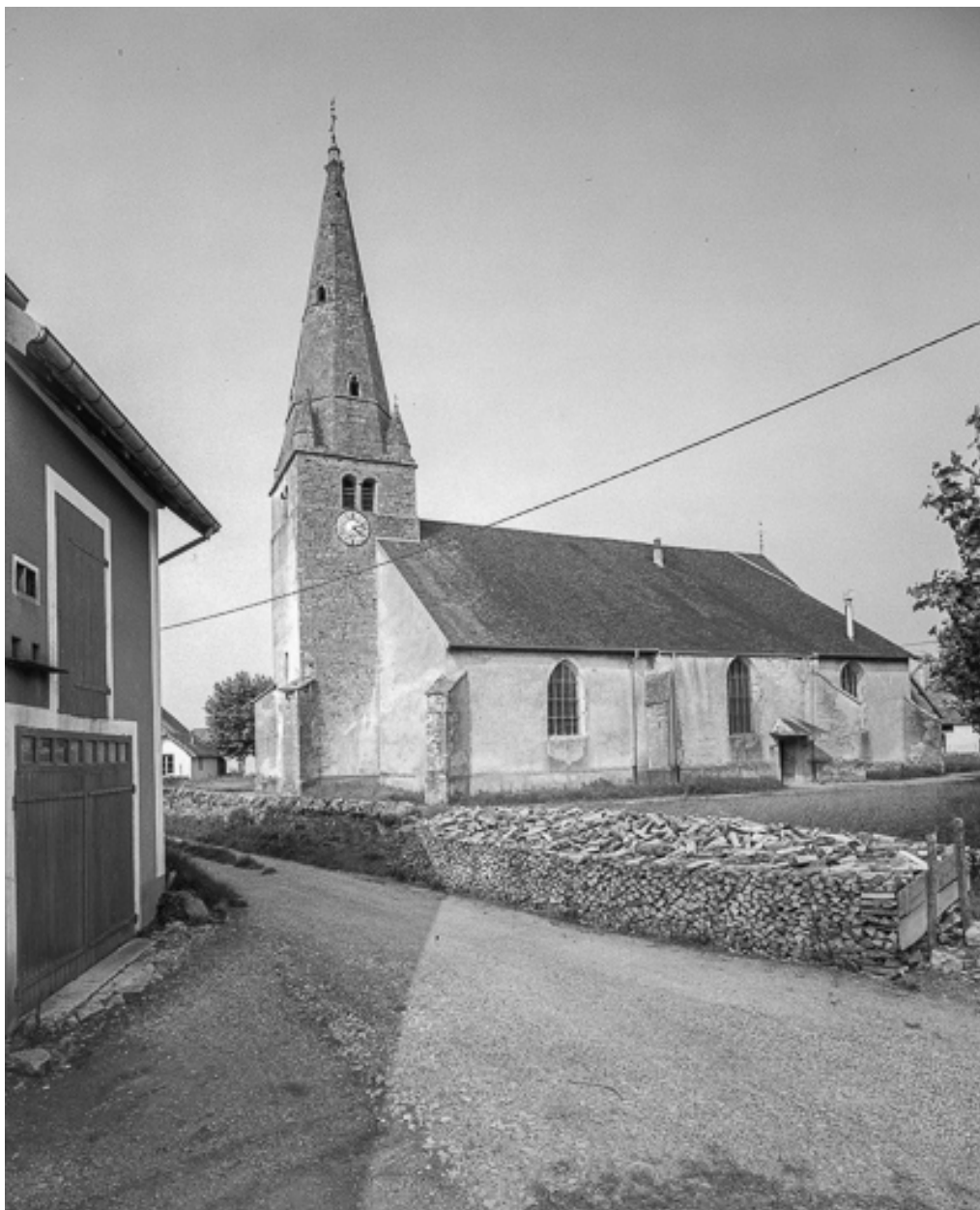
Façade latérale sud.
