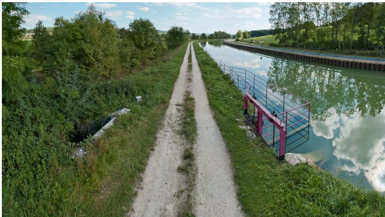
Vue du déversoir.
