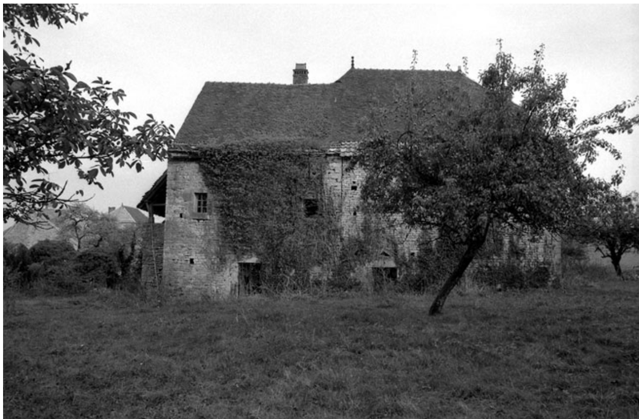
Façade latérale droite.
