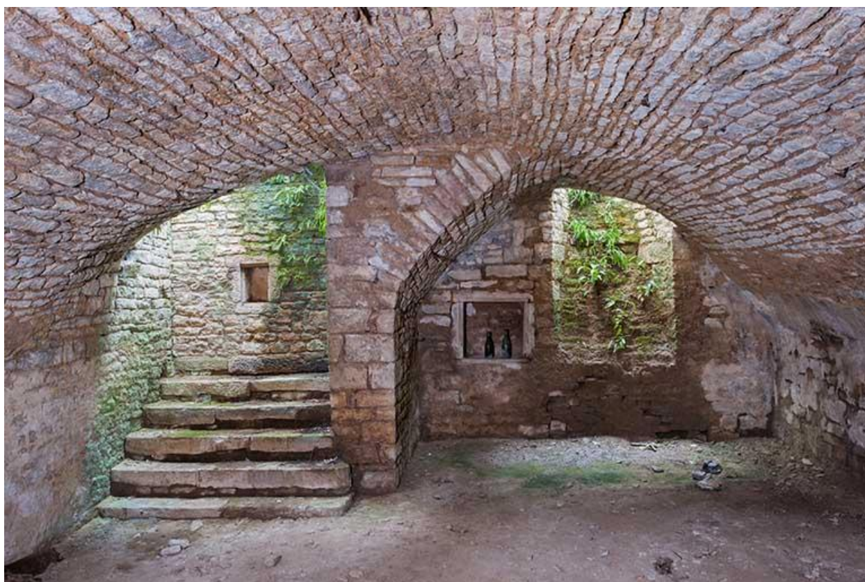
Vue générale de la cave
