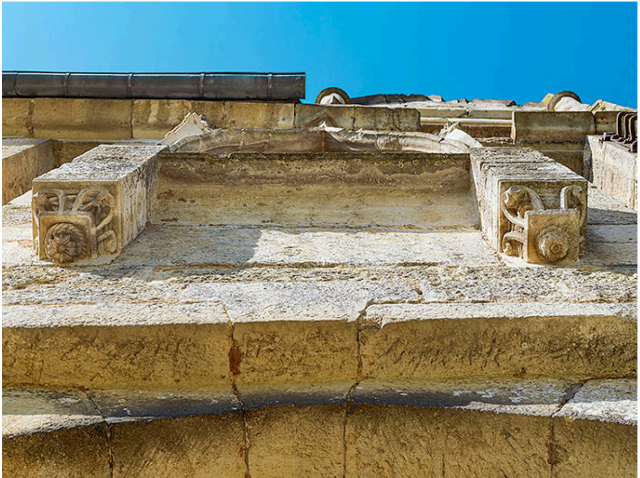
Base des piliers supportant les pinacles.
