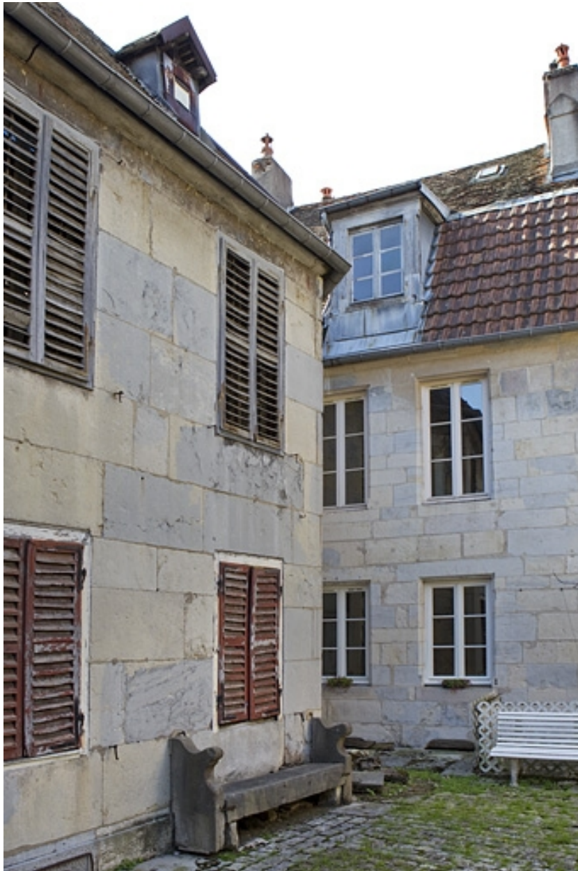
Façades sur la deuxième cour des deux logis secondaires.
