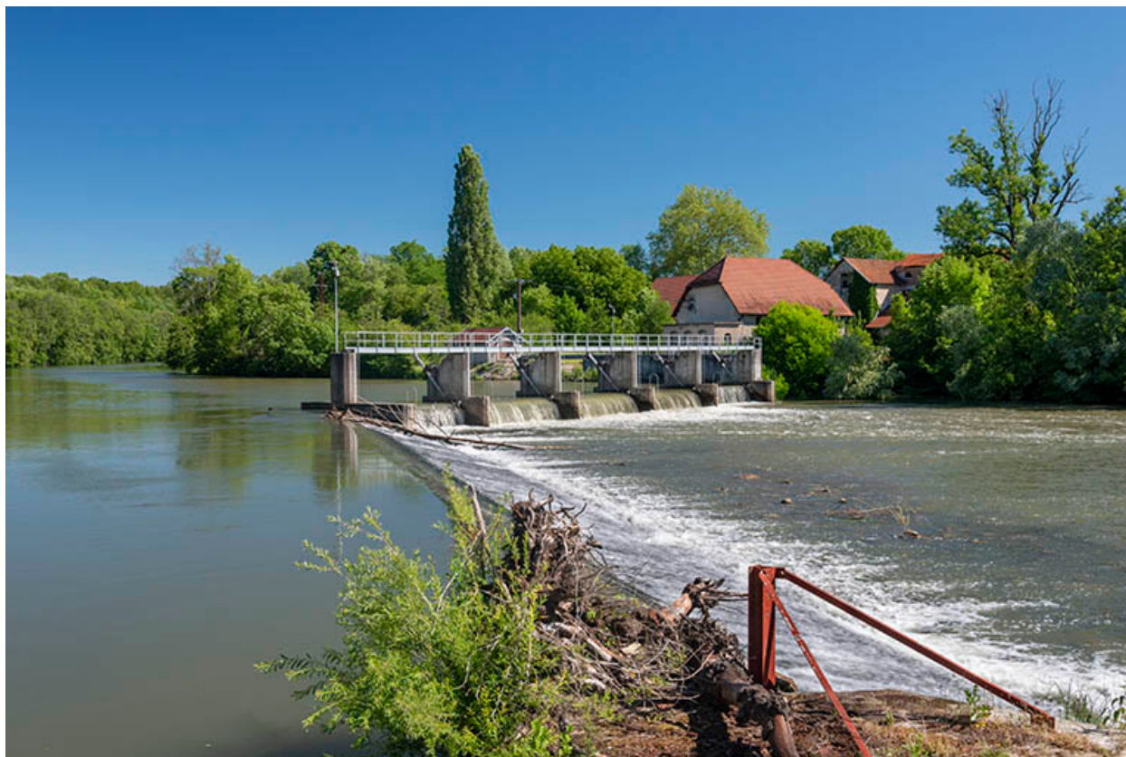
Site du barrage.
