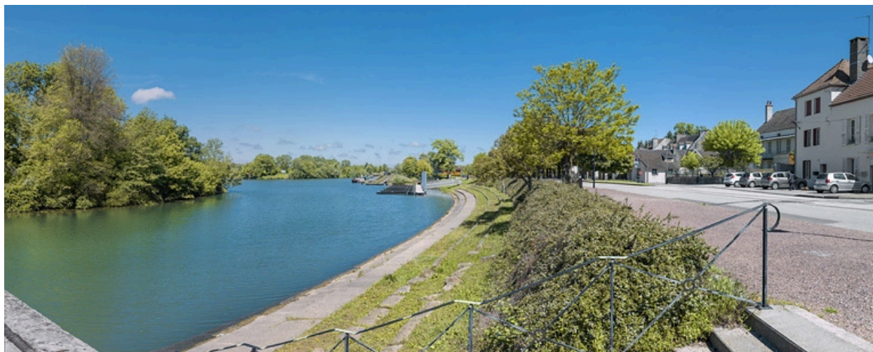
Les quais à gradins de Seurre, avant restauration.
