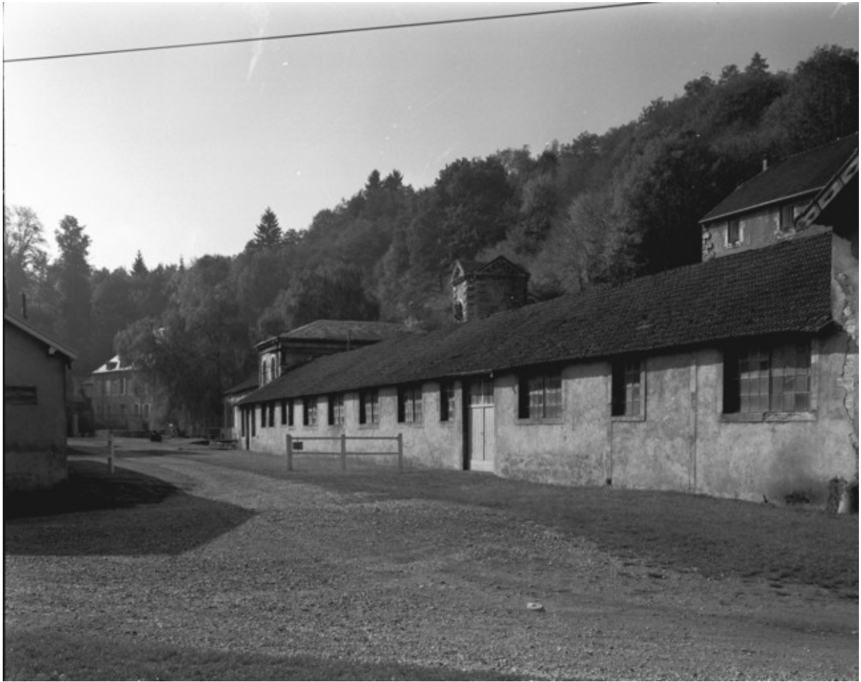
Façade est de l'atelier de fonderie en 1989.
