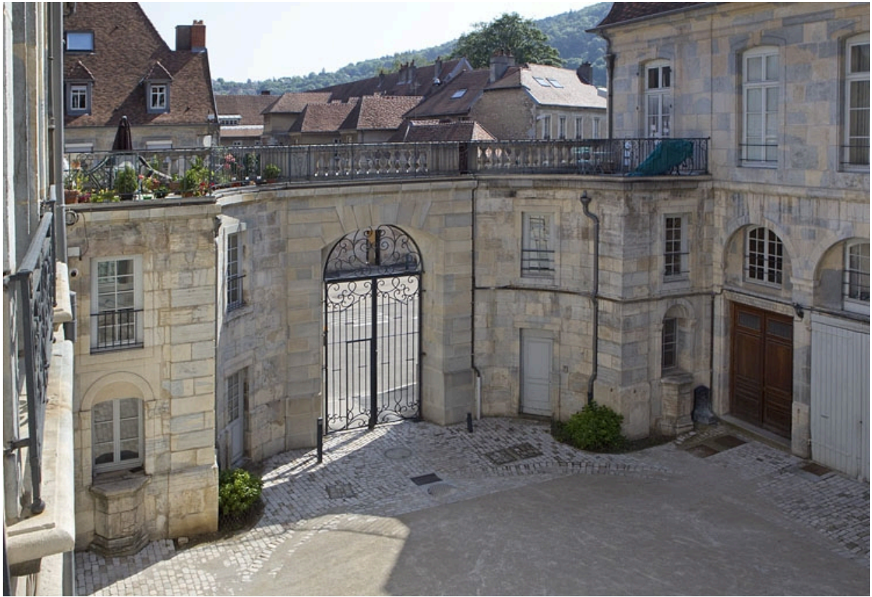
Vue d'ensemble de la clôture sur rue depuis la cour, de trois quarts gauche.
