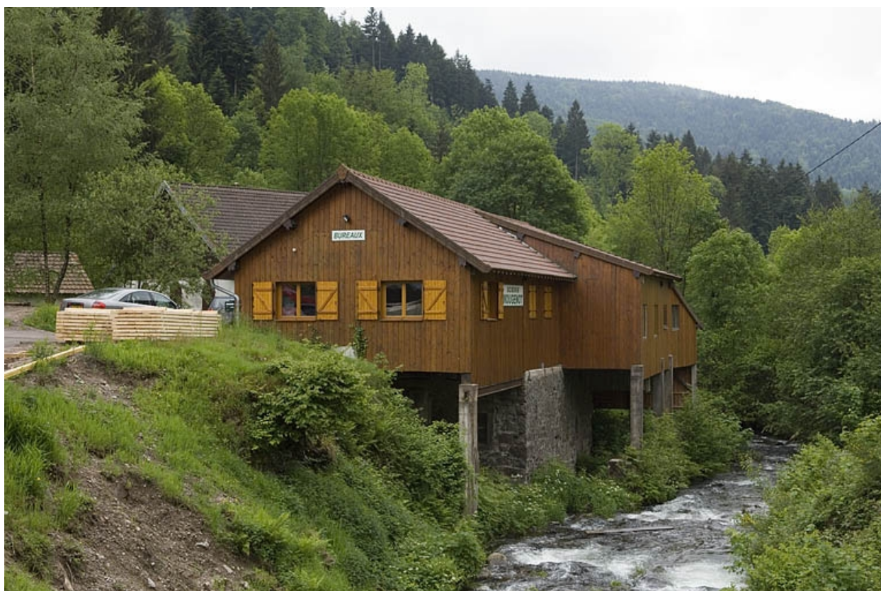
Bâtiment (réhabilité) de la scierie primitive.
