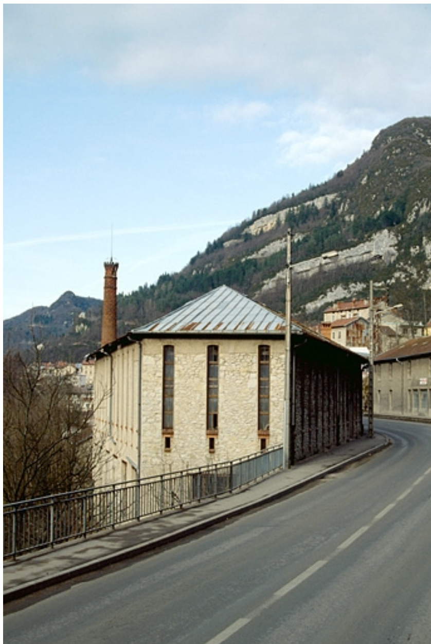
Façade latérale gauche du séchoir à ébauchons.
