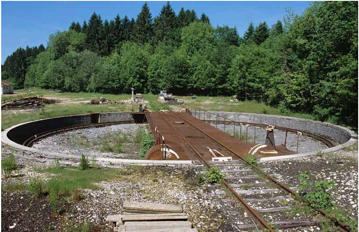
Vue d'ensemble rapprochée.
