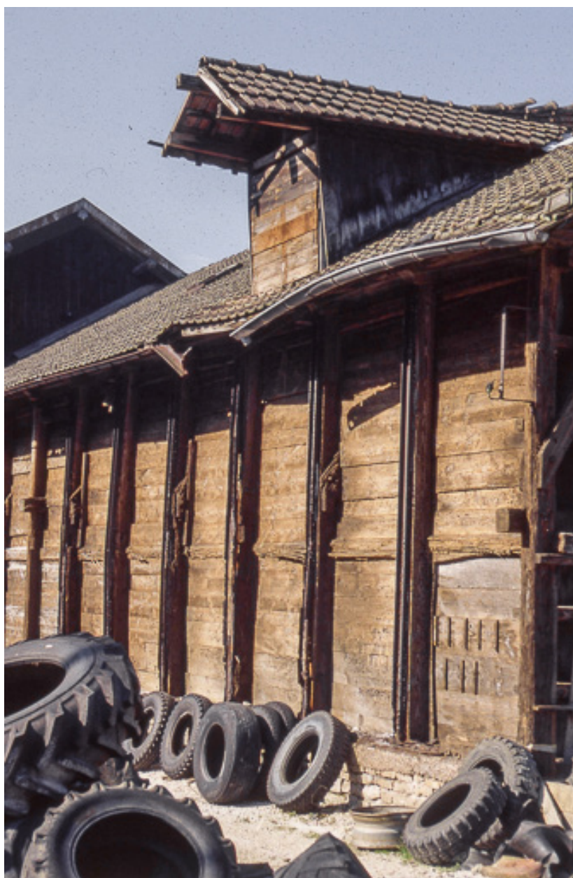
Détail de façade d'un magasin industriel.
