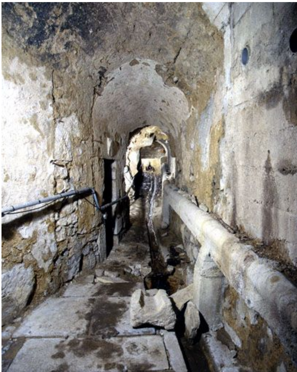
Conduit hydraulique des infirmeries vu depuis l'entrée.
