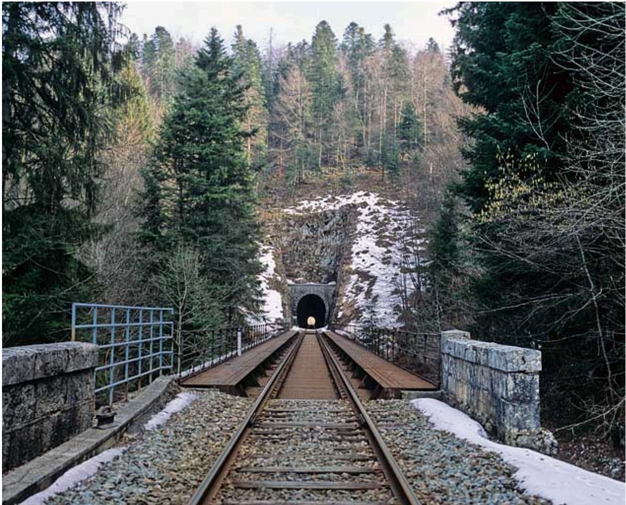
Vue d'ensemble depuis la voie, côté Andelot-en-Montagne.
