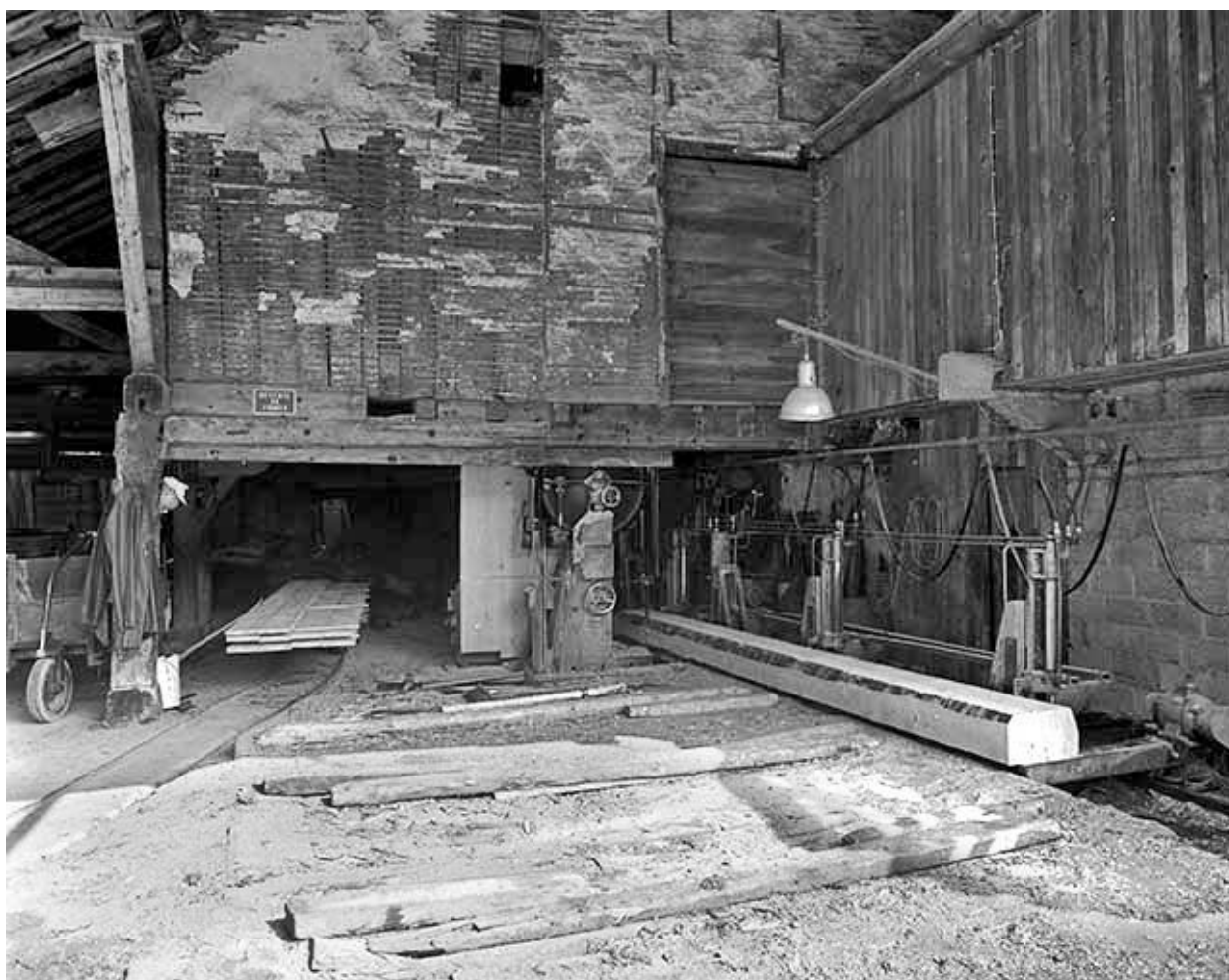
Intérieur de l'atelier de sciage.
