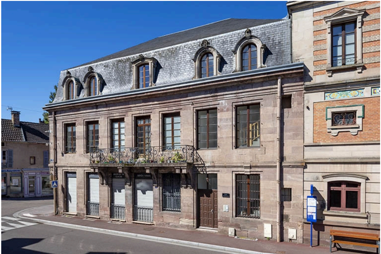
Maison Desgranges, façade est.
